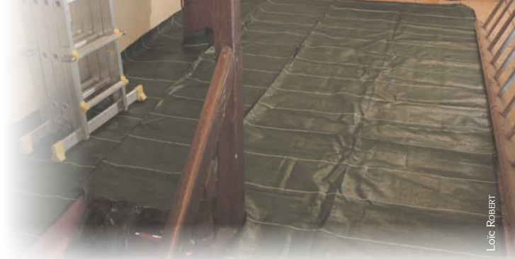
Pose d'une bâche de protection sur le plancher d'une église
